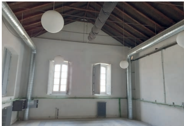
Foto VSI.2. Vista parcial adaptación espacios nave 30 para Grado de Física
