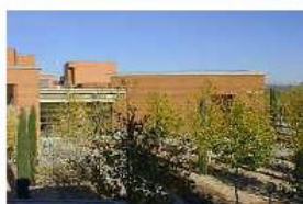
EDIFICIO ENRIQUE COSTA NOVELLA Ingeniería Química
